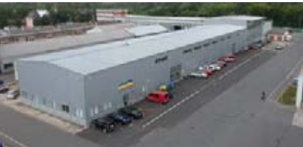
Fertigungswerk | CZ – Ostrava
